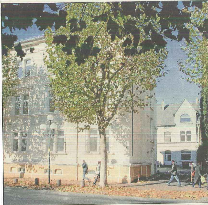
In dieses Gebäude in der Ludwigstraße soll die Kita umziehen.
