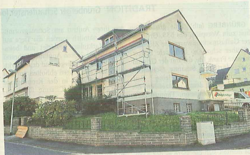
Das Zweifamilienhaus wird zurzeit noch für die Flüchtlinge umgebaut.
